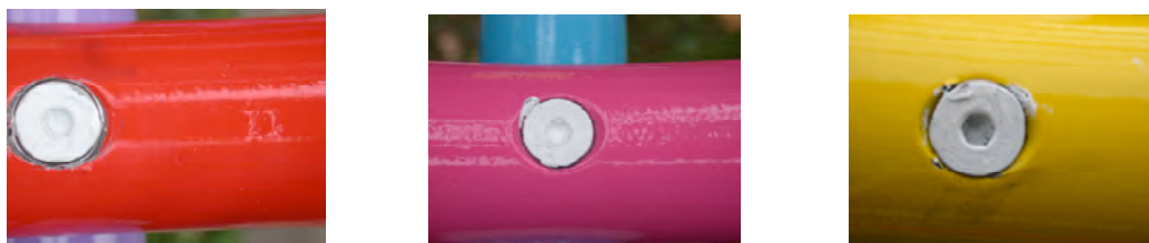
Photos 22, 23 et 24 : Peinture blanche deux composants appliquée sur toutes les têtes de vis.
