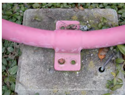
Photo 25 : Anneau du bas avec le mode d'accroche au sol, on voit les différents repeints et le système de paratonnerre.
