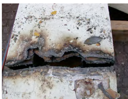
Photo N° 3 : Stratigraphie de la construction
