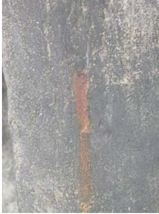
Photos 7 et 8: Spuren von Eisenoxyd; teilweise Entfernung der roten Tonerde des Kerns
