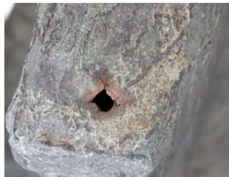
Photos 11, 12, et 13 : Risse und Löcher im Guss
