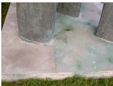
Photo 21: Behandlung zur Entfernung des Kupfersalzes in Gange
