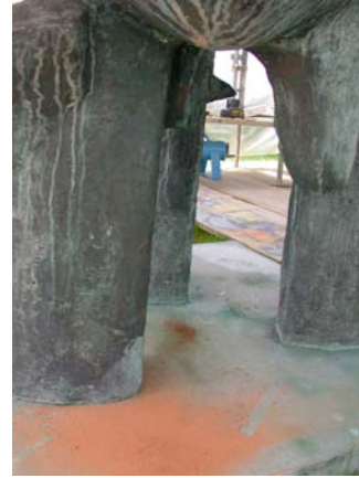
Photos 7 et 8: Spuren von Eisenoxyd; teilweise Entfernung der roten Tonerde des Kerns
